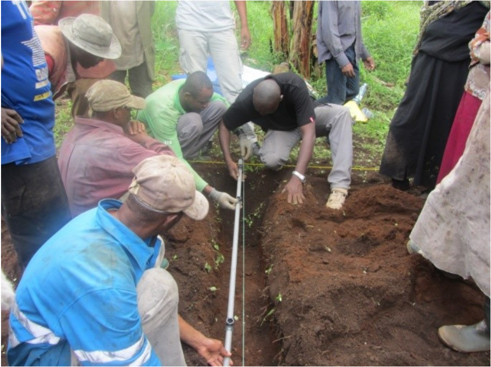
Formation de 35 paysans formateurs en installation et entretiens des kits d'irrigation goutte à goutte aux Comores (programme VNU, 2014)
