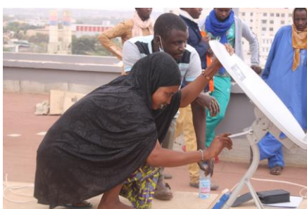
Photo de gauche : Formation en installation photovoltaïque à Bamako
